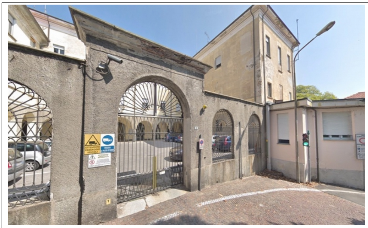
VISTA DEL FRONTE DI INGRESSO DALLA CORTE SU VIA GARELLI
