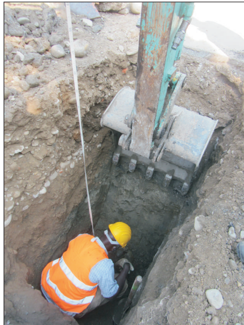
Vista dello scavo effettuato.
