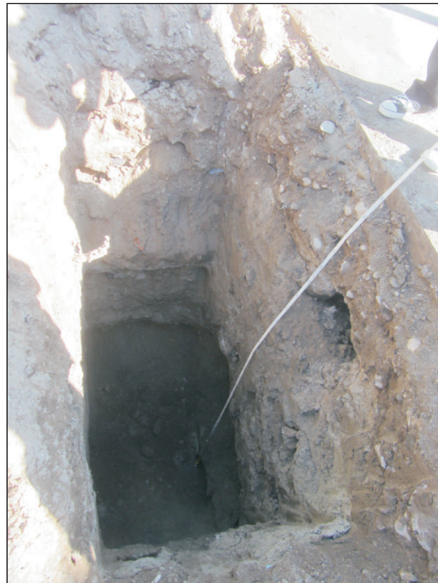
Vista dello scavo effettuato.
