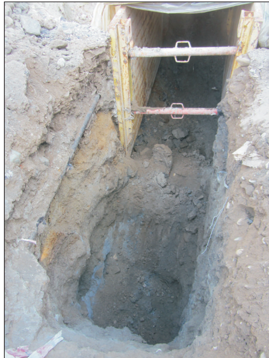
Vista dello scavo effettuato.
