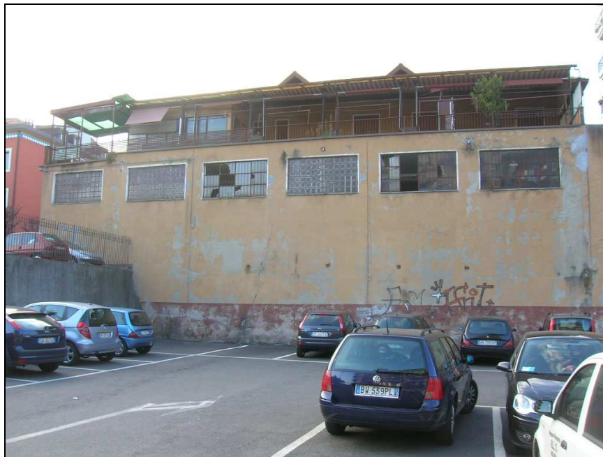
FIGURA 3 - EDIFICIO DI PROPRIETA' CAVALLI VISTO DA PIAZZA CARLO BARBERI
