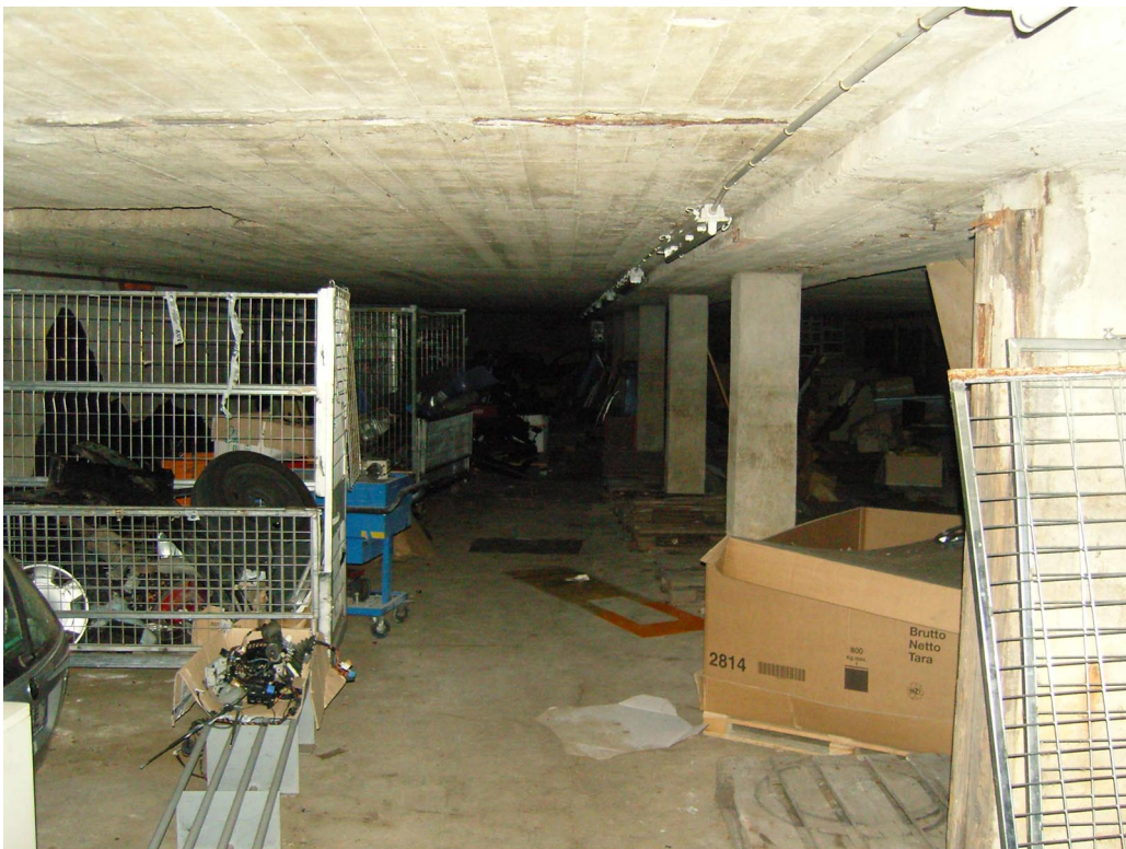
Foto 19 –20 : seminterrato del Fabbricato B, adibito a magazzino: si notino le tracce di umidità dovute alla periodica risalita della falda.
