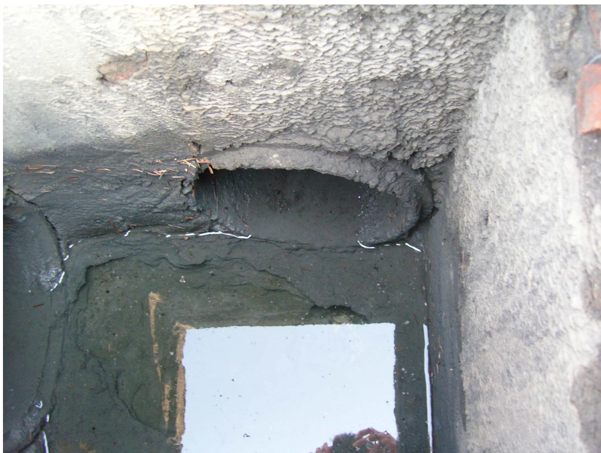
Foto 4-7: particolari del sistema di raccolta e recapito in fognatura delle acque nere.
