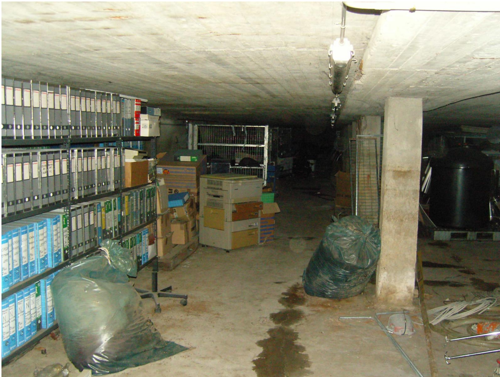
Foto 19 –20 : seminterrato del Fabbricato B, adibito a magazzino: si notino le tracce di umidità dovute alla periodica risalita della falda.
