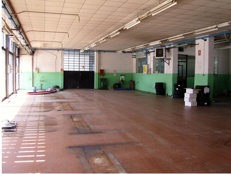
Foto 17: autofficina – Fabbricato B.
