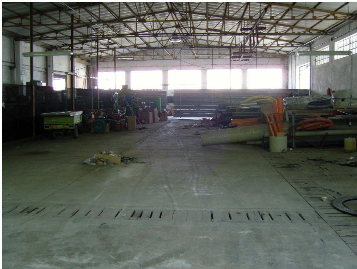
Foto 16: porzione del fabbricato C adibita a laboratorio prove materiali.
