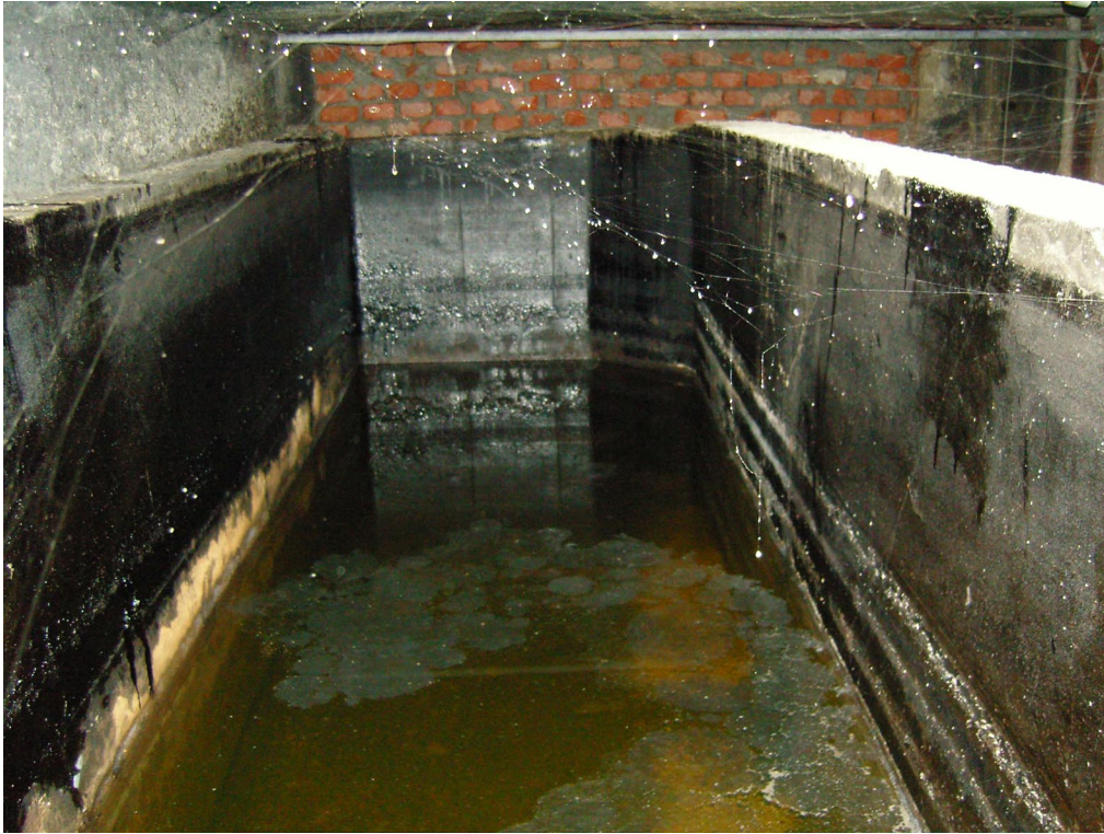
Foto 9: la vasca probabilmente destinata alla concia pelli nel Fabbricato C.
