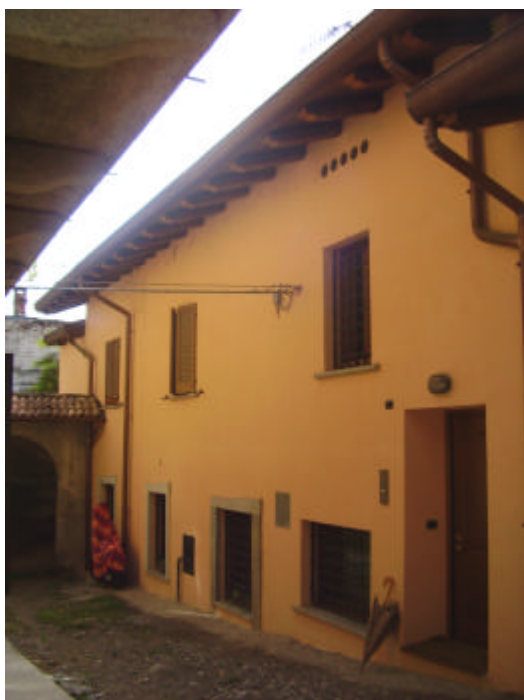
Foto 1. Prospetto lungo vic. Curioni
