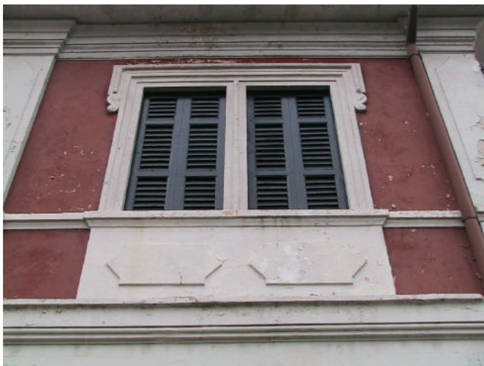
Foto 4. Dettaglio delle cornici delle finestre
