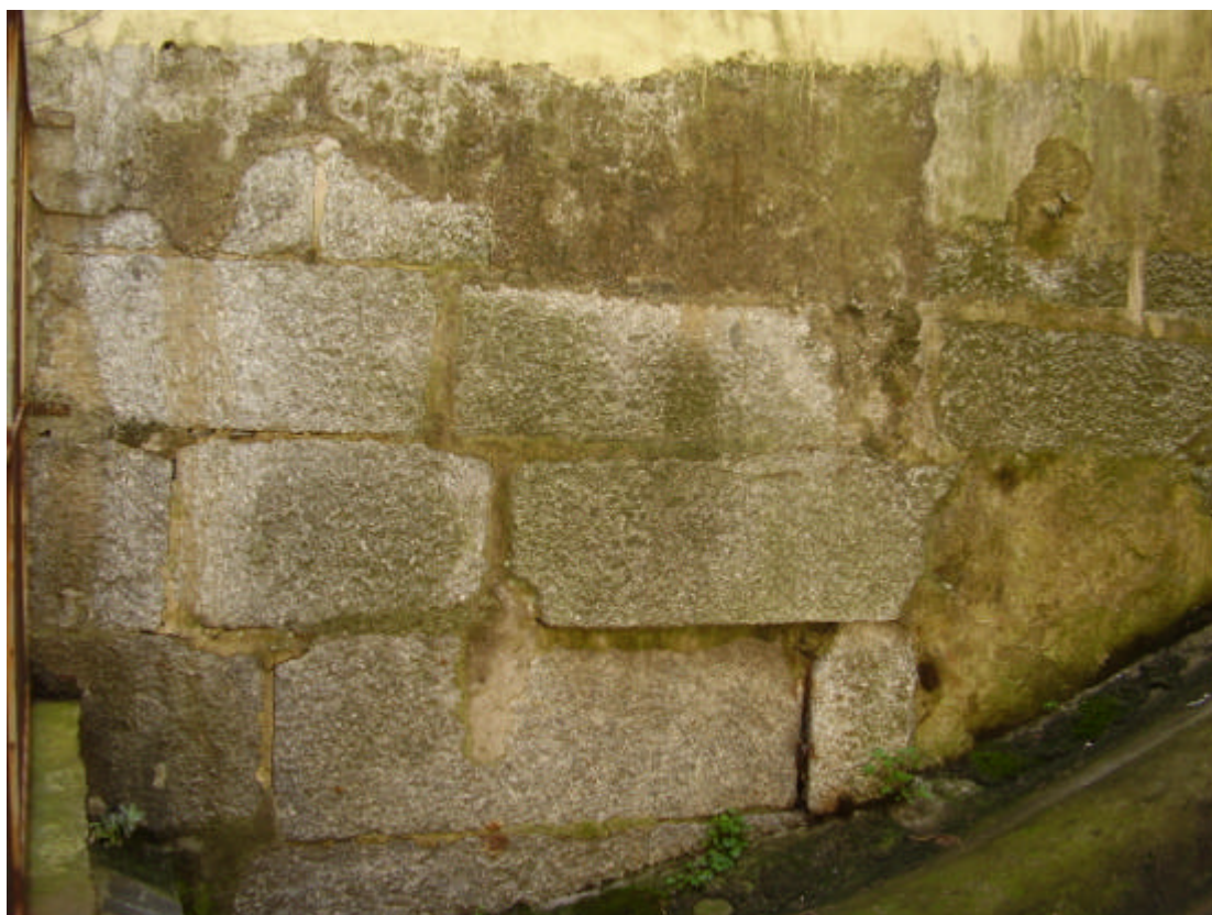
Foto 3. La muratura in blocchi lapidei
