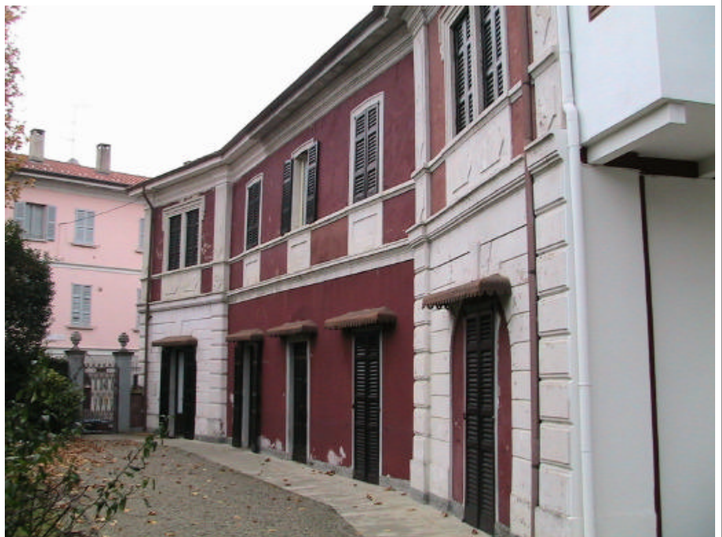
Foto 3. Prospetto interno verso il cortile
