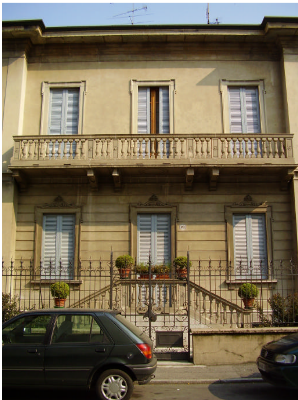
Foto 2. Scalea di ingresso e balcone e balaustrini
