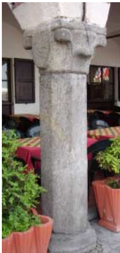
Foto 3/4. Dettagli – colonna e arco di scarico in laterizio
