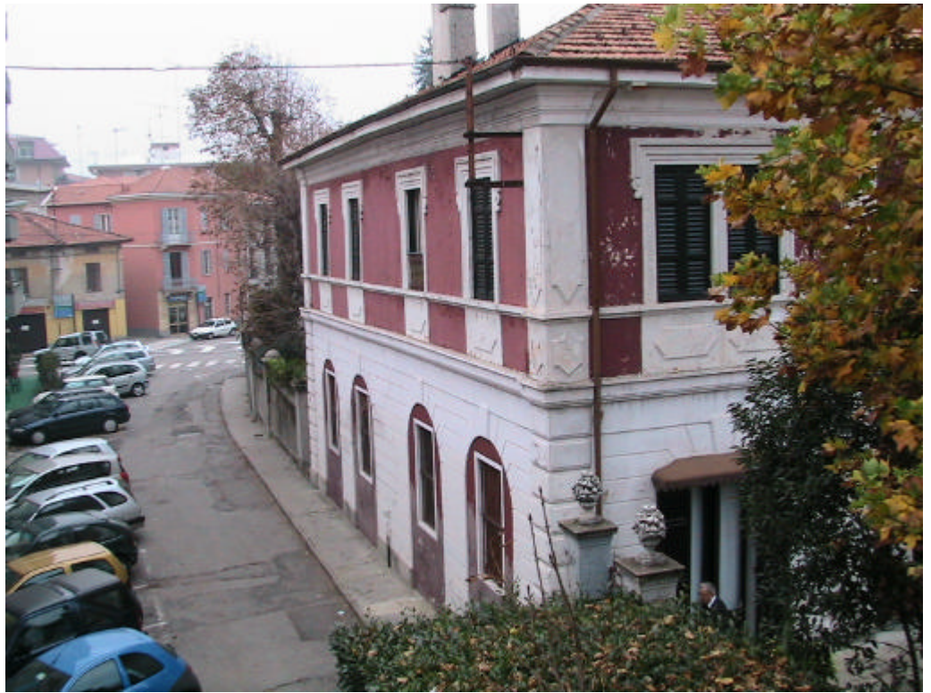
Foto 2. Prospetto laterale verso Largo Compiegne
