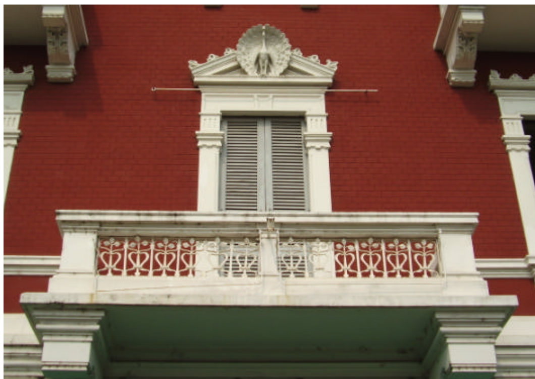
Foto 2. Dettaglio – Balcone e cornici con trabeazione
