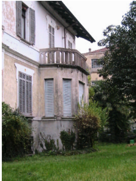
Foto 3/4. Dettagli del bowindow e cornici delle aperture
