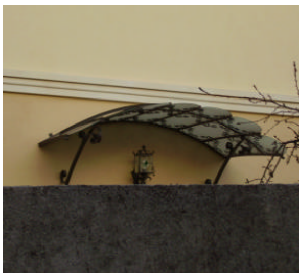
Foto 3/4. Dettaglio della pensilina in ferro e vetro e della cornice delle finestre
