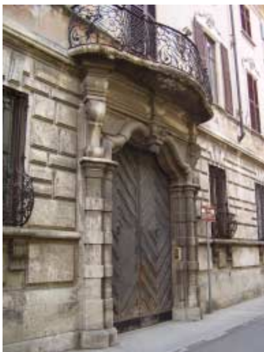
Foto 5/6. Dettagli dei portali lungo via S. Carlo e Viale Berrini
