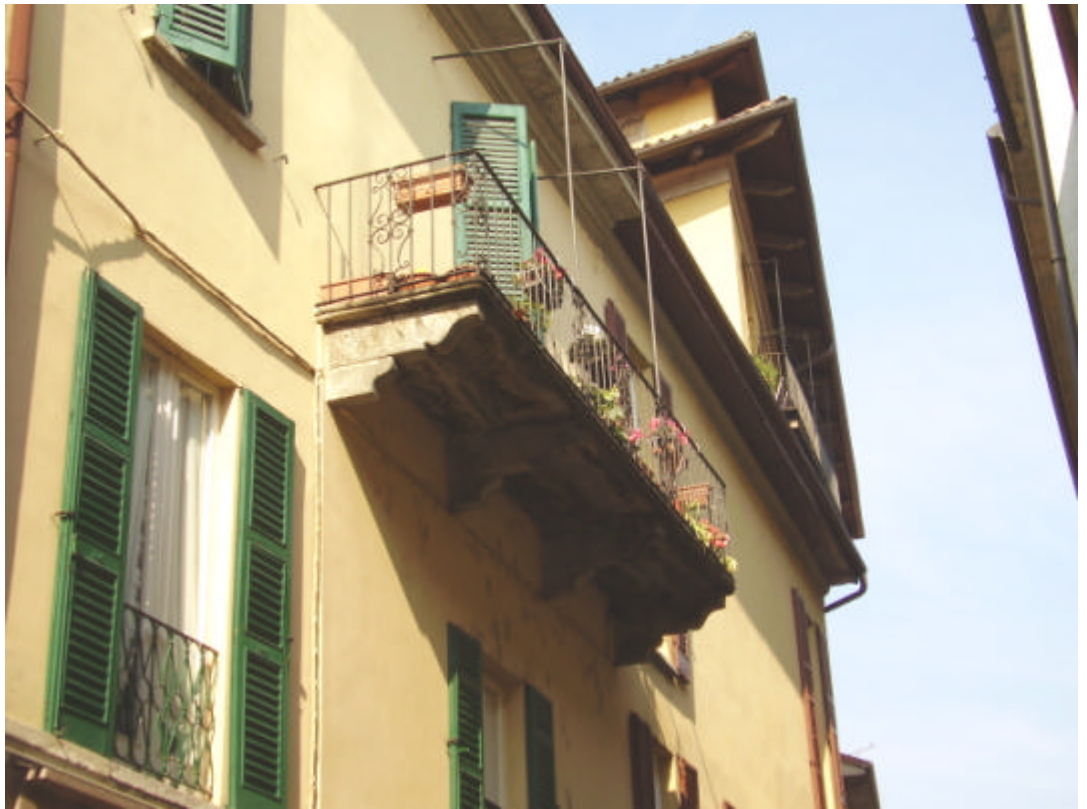
Foto 3. Dettaglio balcone su mensole lapidee
