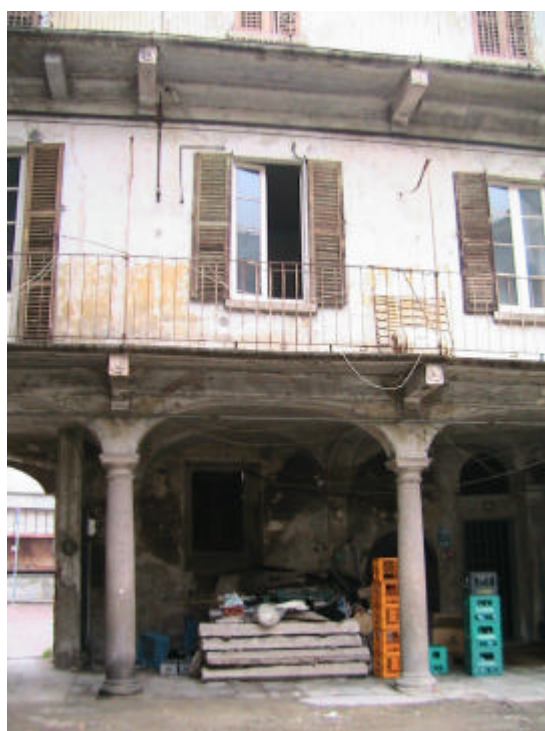
Foto 5/6. Portico di accesso con volte a crociera
