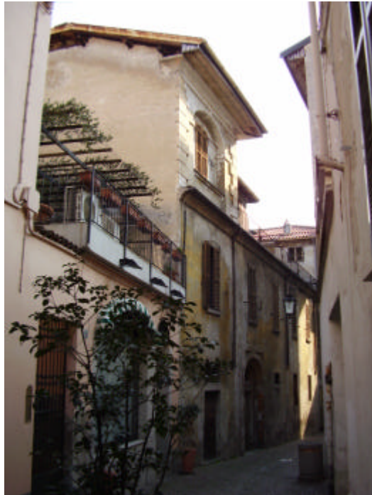
Foto 9-10. Prospetto su vicolo Ponzone e dettaglio del portale di accesso
