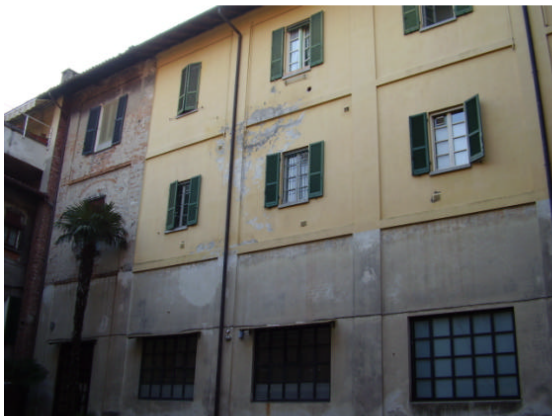
Foto 4. Cortile interno Ex Casa Pirola
