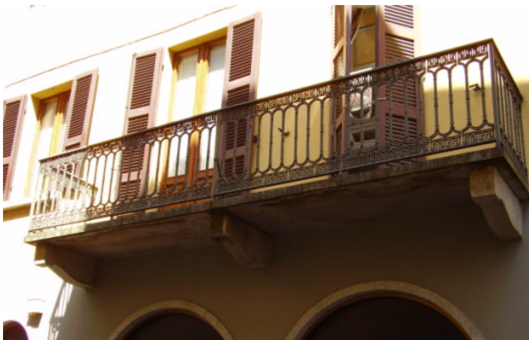
Foto 3. Balcone lapideo con ringhiera in ghisa
