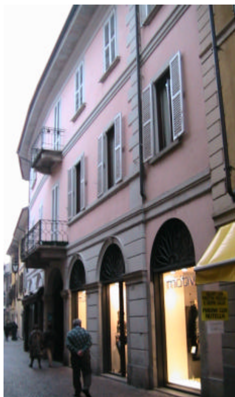
Foto 2-3. Inserimento ambientale C.so Cavour e prospetto interno
