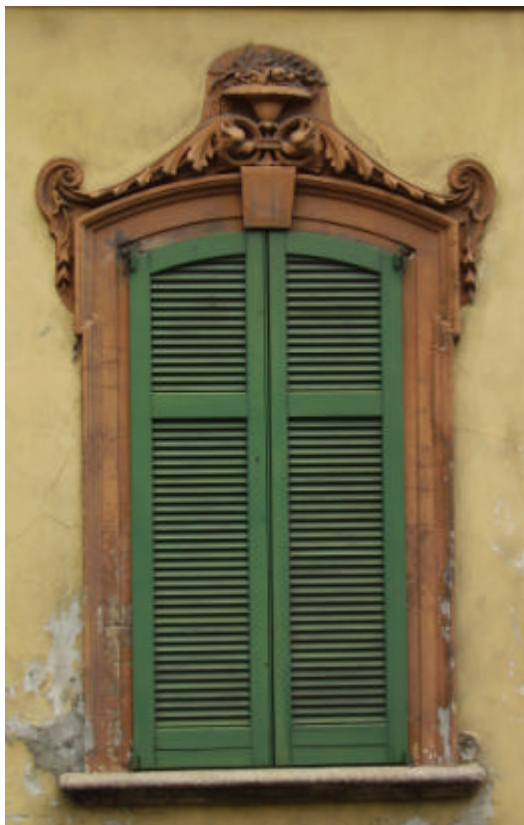
Foto 3/4. Dettaglio cornici piano terra e piano primo
