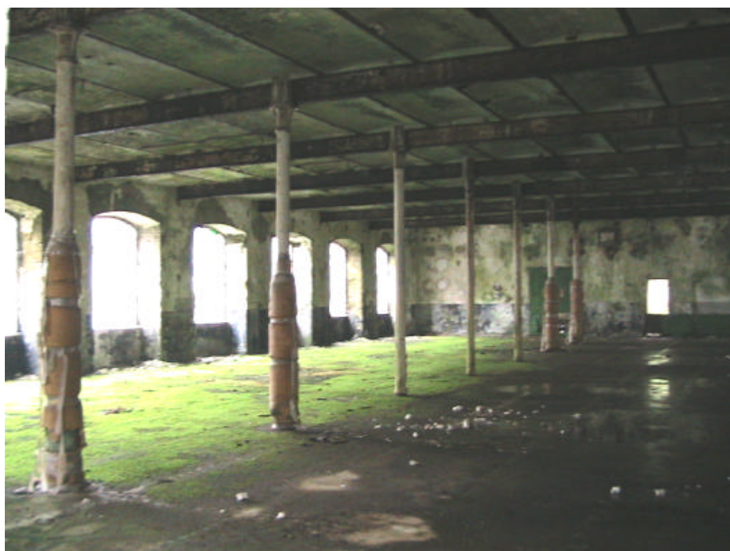
Foto 3. Dettaglio della struttura puntiforme in ghisa
