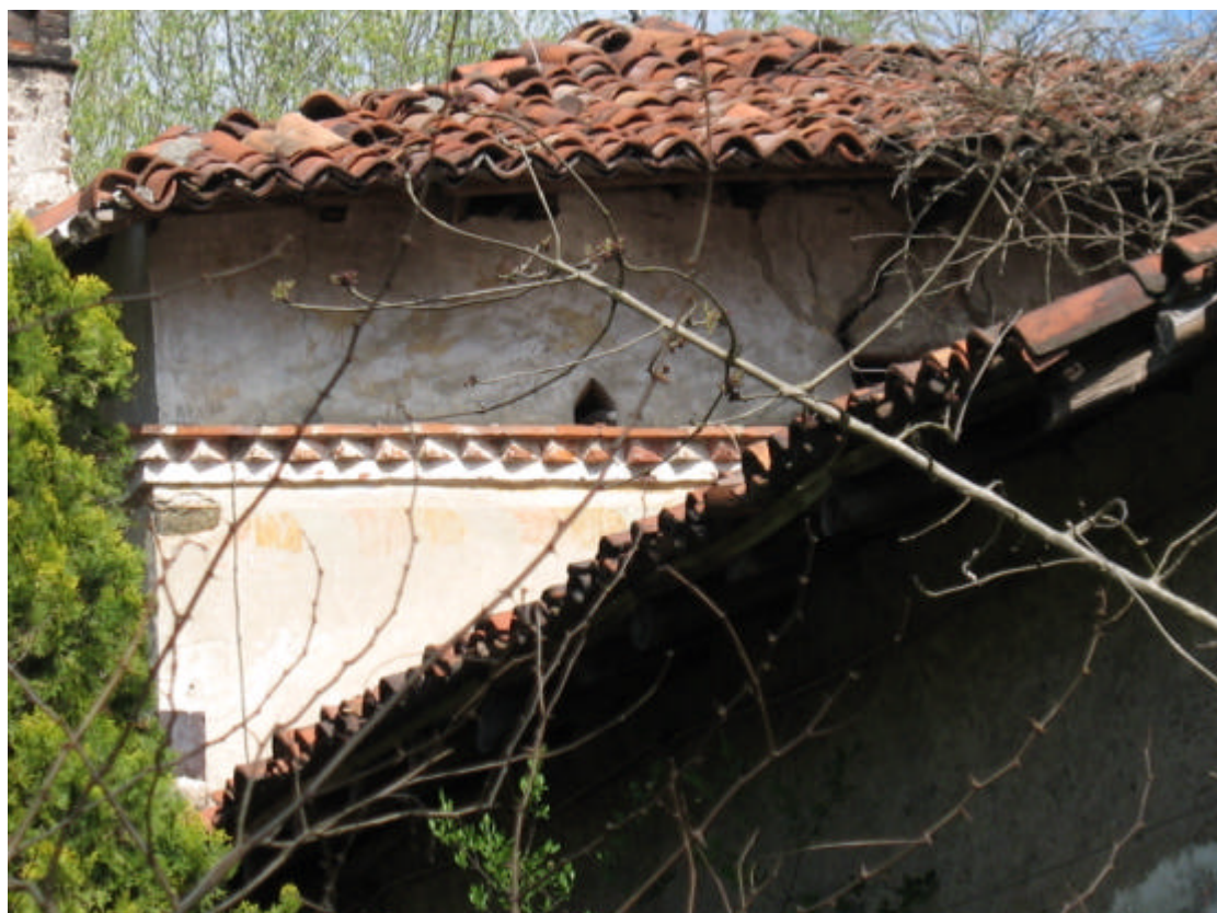
Foto 2. Dettaglio della torre colombaia
