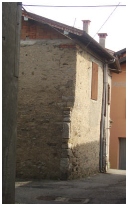
Foto 1-2. Inserimento ambientale e dettaglio del cantonale
