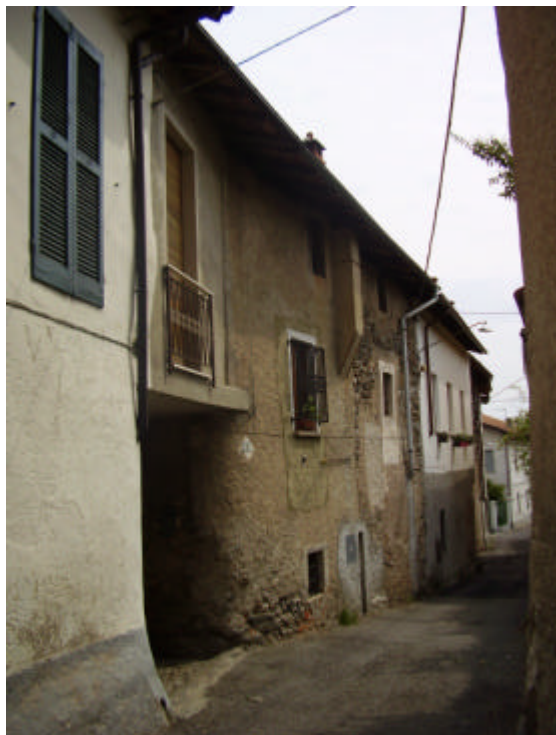
Foto 2-3. Prospetti lungo via Cristoforo Colombo
