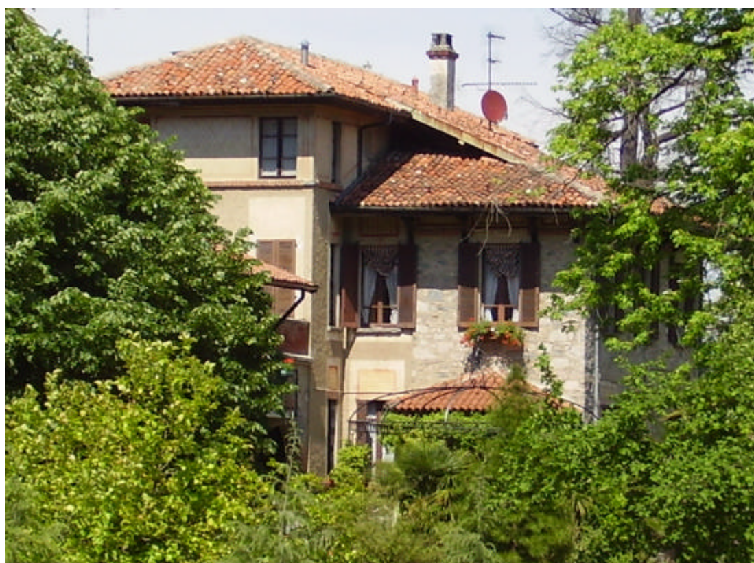
Foto 2. Scorcio dell'edificio principale
