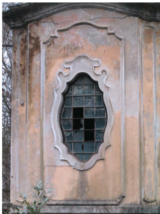
Foto 2-3. Dettaglio delle cornici in stucco
