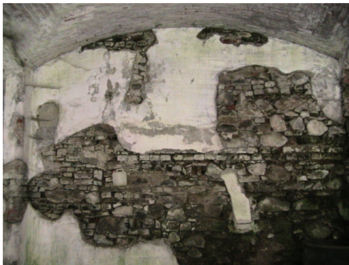
Foto 3. Muratura a piano terra in pietrame misto
