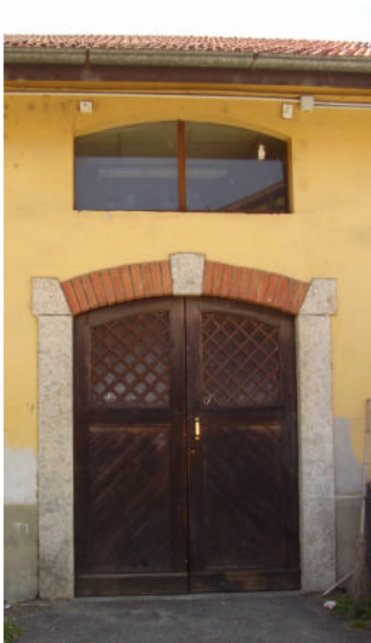
Foto 5-6. Dettagli delle aperture
