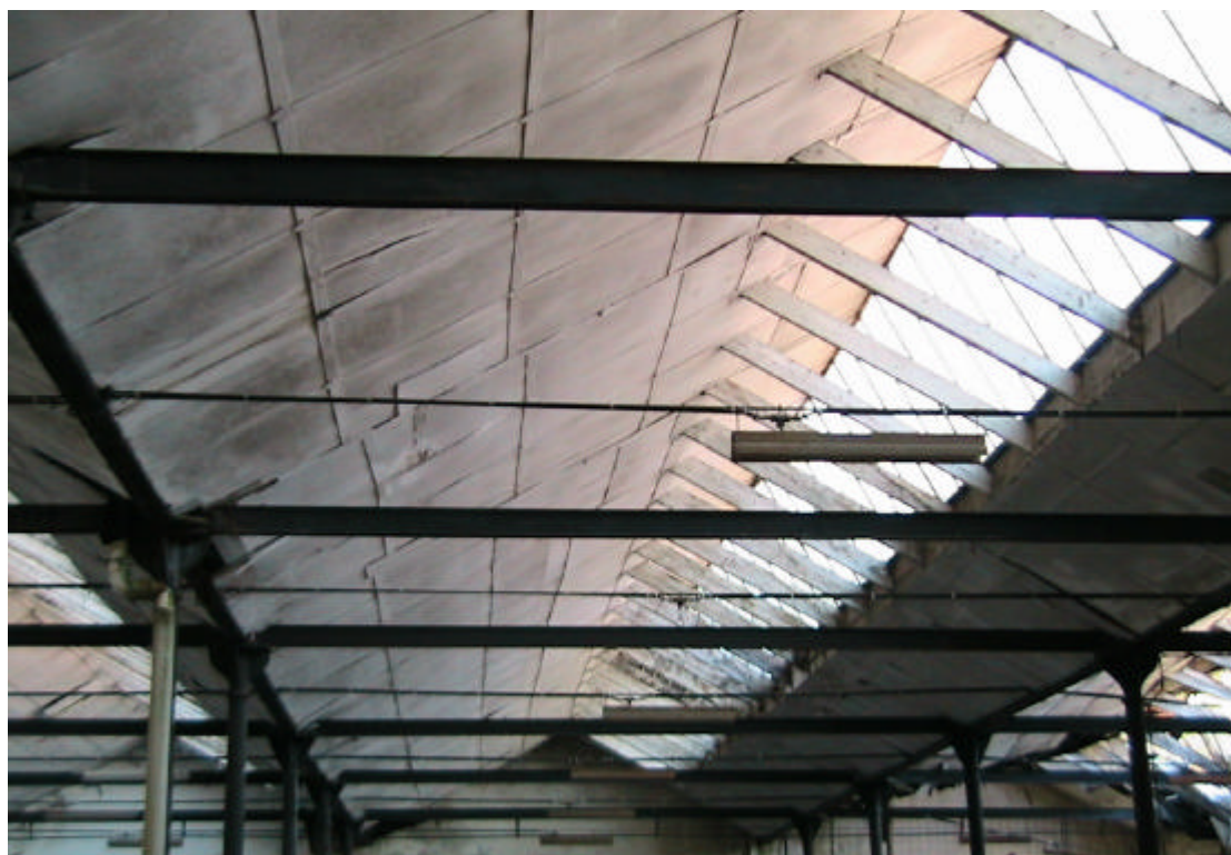
Foto 3. Copertura a shed triangolari
