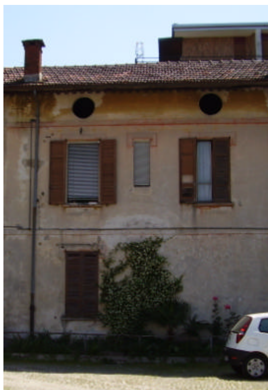
Foto 3-4. Palazzina degli uffici e meridiana
