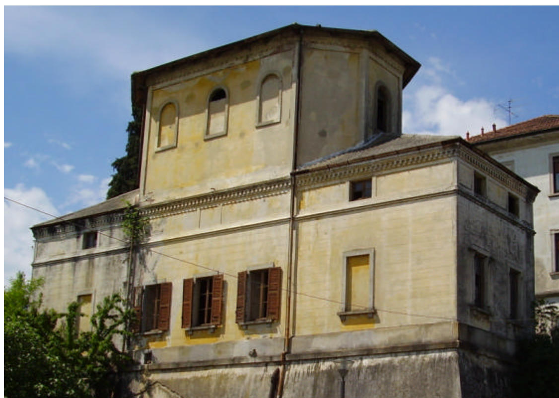
Foto 3. Edificio su 2 livelli
