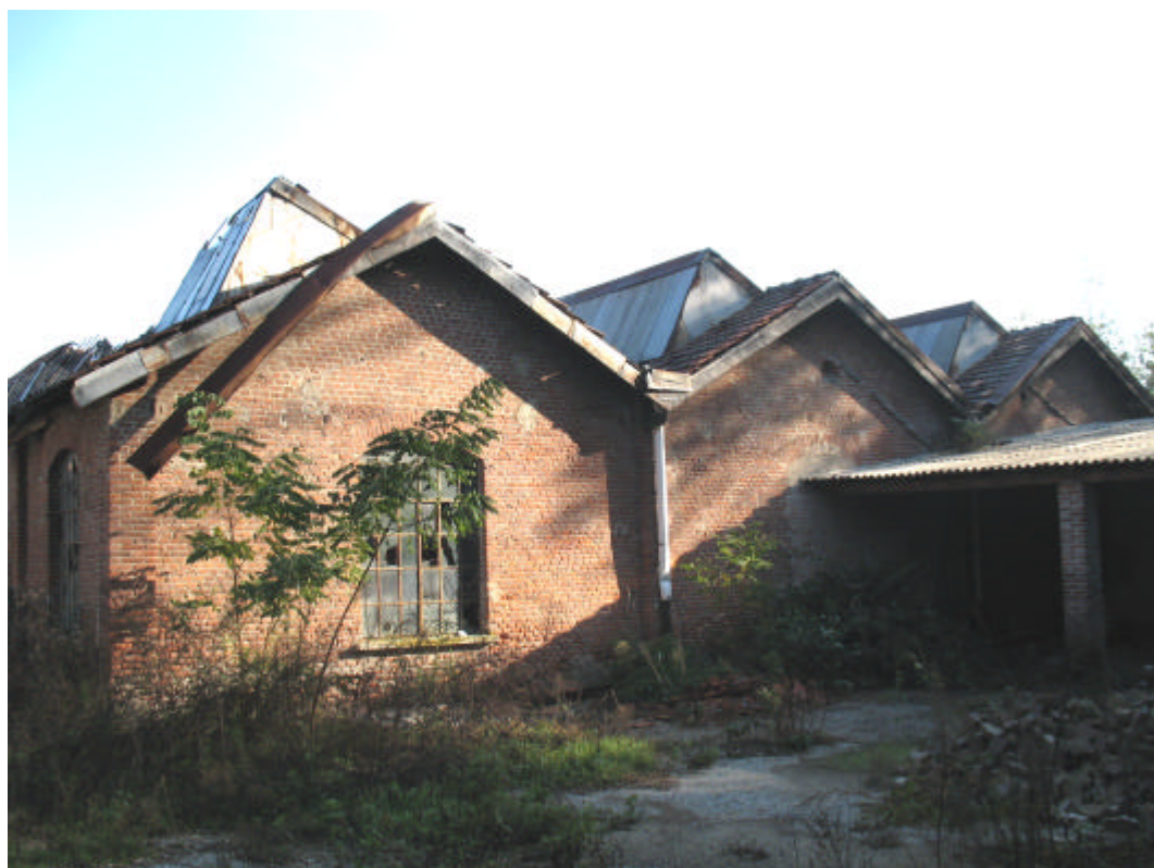
Foto 2. Stabilimento con copertura a shed
