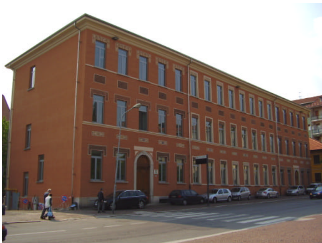
Foto 3. Tratto 7c inglobate nella muratura delle Ex Scuole Nicotera (CIV_06)
