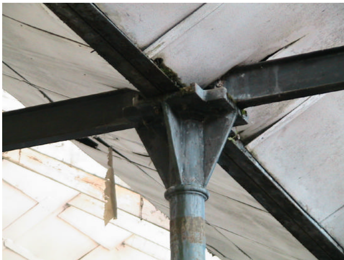
Foto 4. Struttura puntiforme in ghisa
