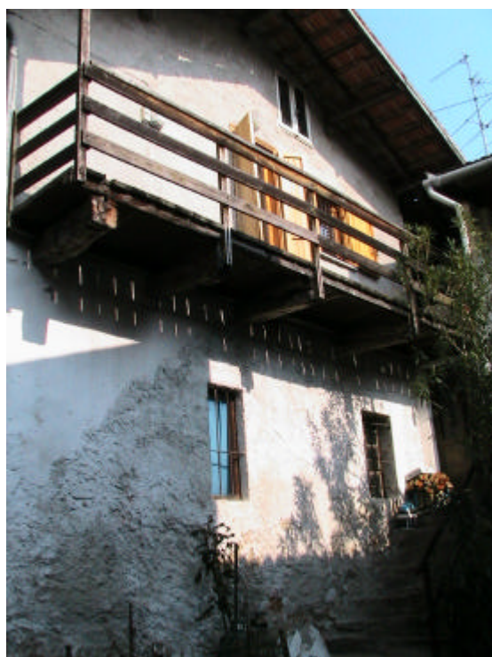
Foto 6-7. Caseggiati rurali - Prospetti interni alla corte
