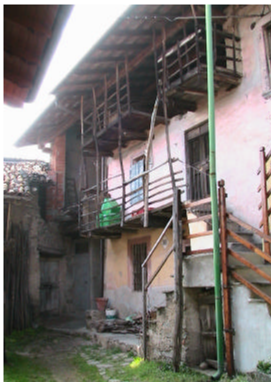
Foto 4-5. Caseggiati rurali – Prospetti interni alla corte
