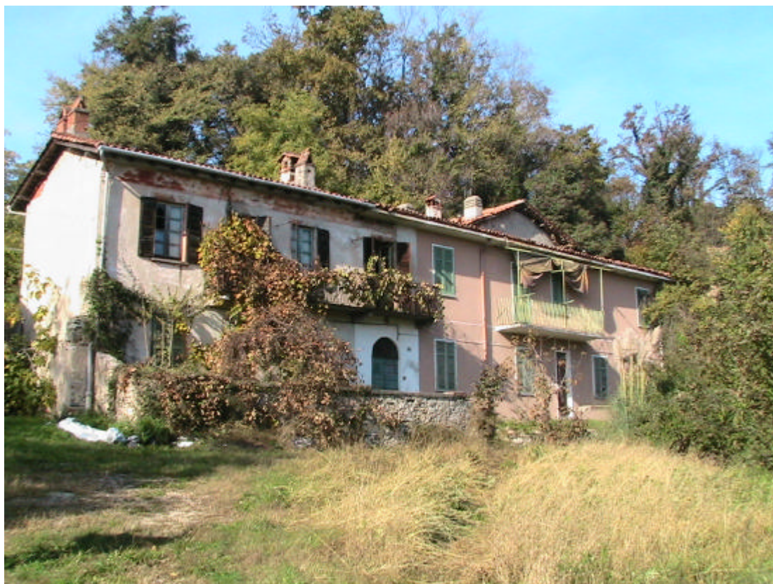
Foto 2. Prospetto est corpo principale
