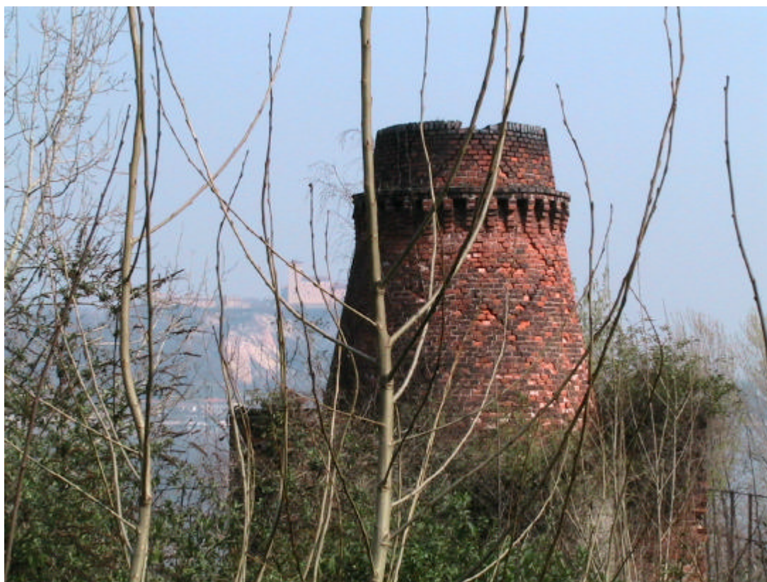
Foto 2. Dettaglio della ciminiera
