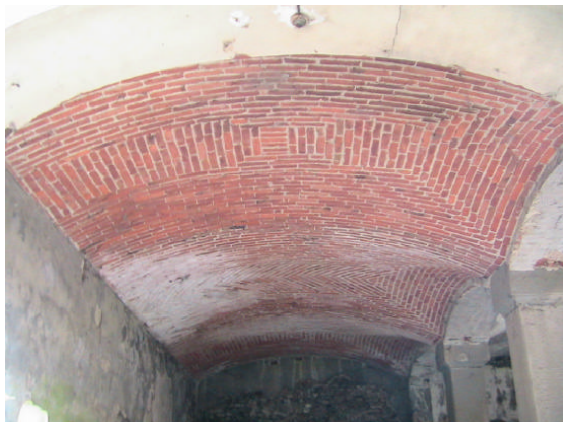
Foto 2. Volte a vela del portico a piano terra
