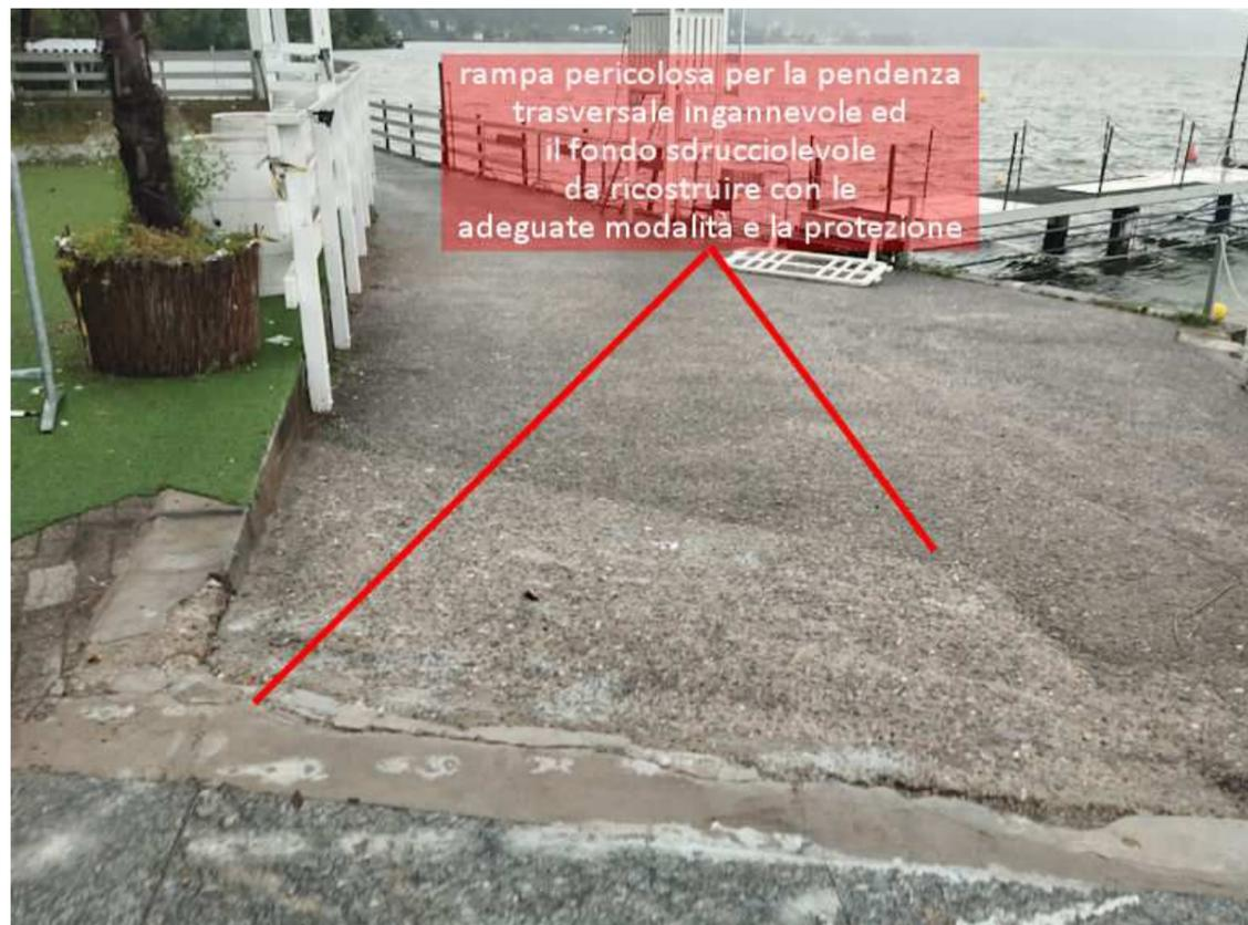
rampa pericolosa per la pendenza trasversale ingannevole ed il fondo sdruciolevole da ricostruire con le adeguate modalità e la protezione
