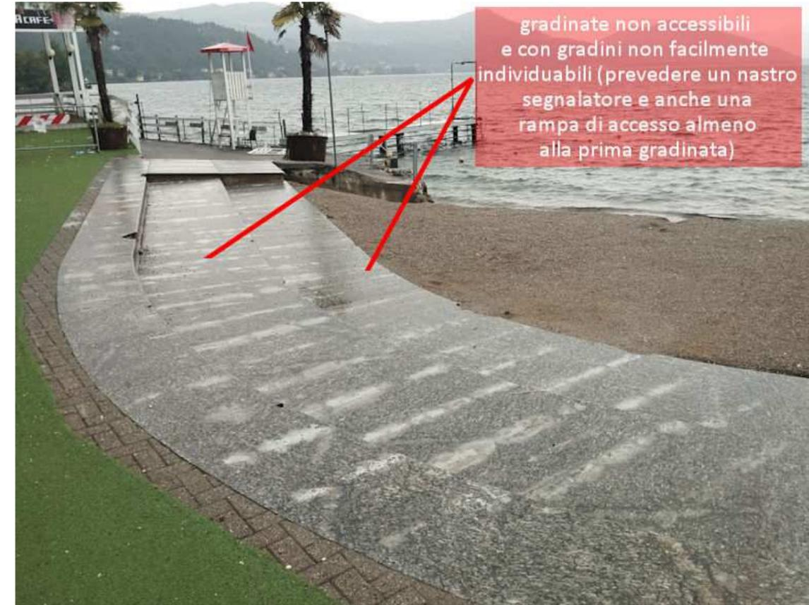
gradinate non accessibili e con gradini non facilmente individuabili (prevedere un nastro segnalatore e anche una rampa di accesso almeno alla prima gradinata)
