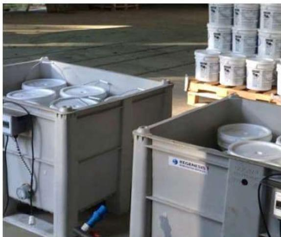
Figura 4 Fustini di HRC in vasche di pre-riscaldamento
