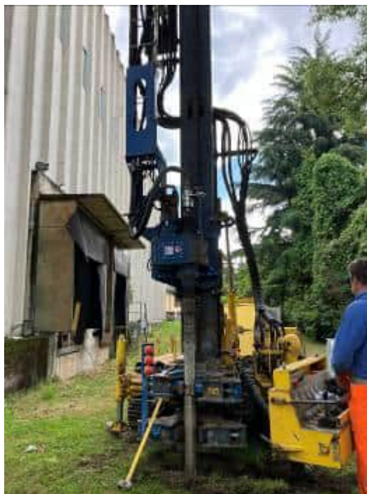
Foto 5: Posizionamento sonda per inizio perforazione.
