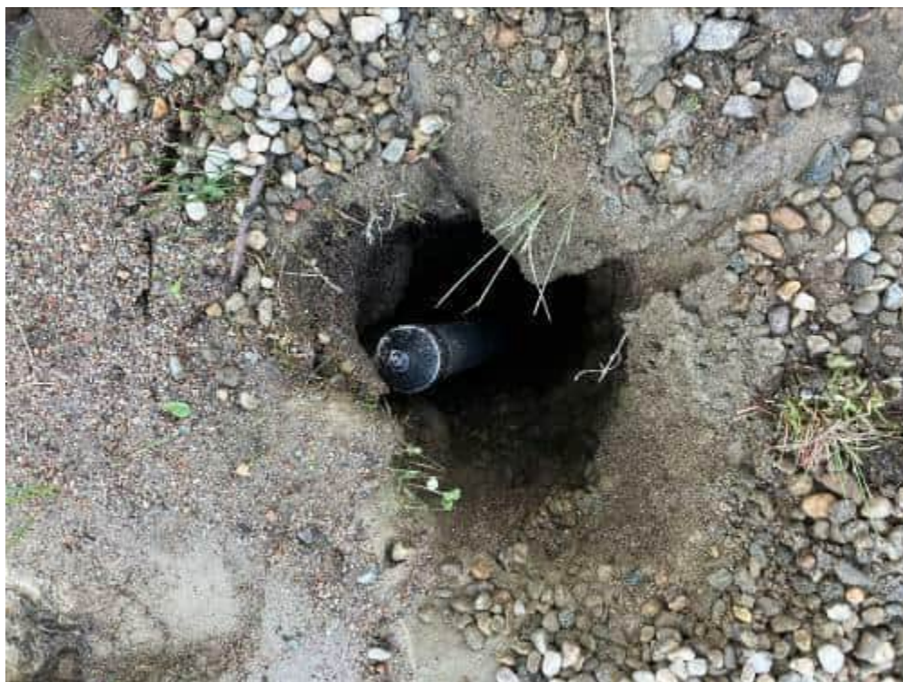
Foto 8: Tubi valvolati installati
