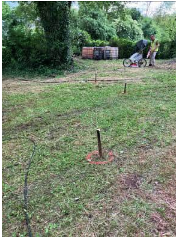
Foto 1: Individuazione punti di iniezione tramite indagine georadar (area BH16)
