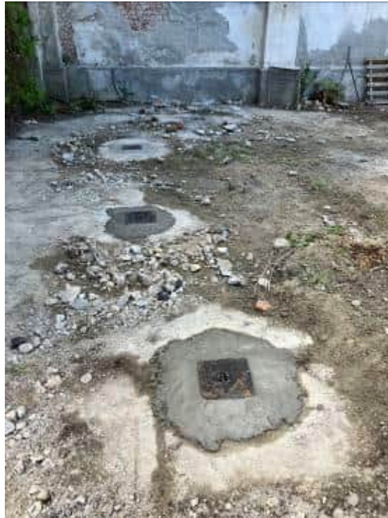
Foto 9: Pozzi di iniezione completati (area BH18)
