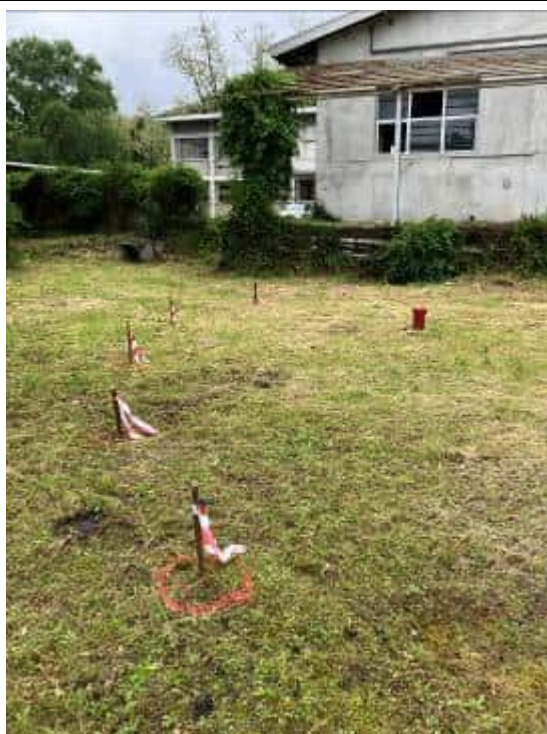
Foto 3: Individuazione punti di iniezione tramite indagine georadar (area BH11)
