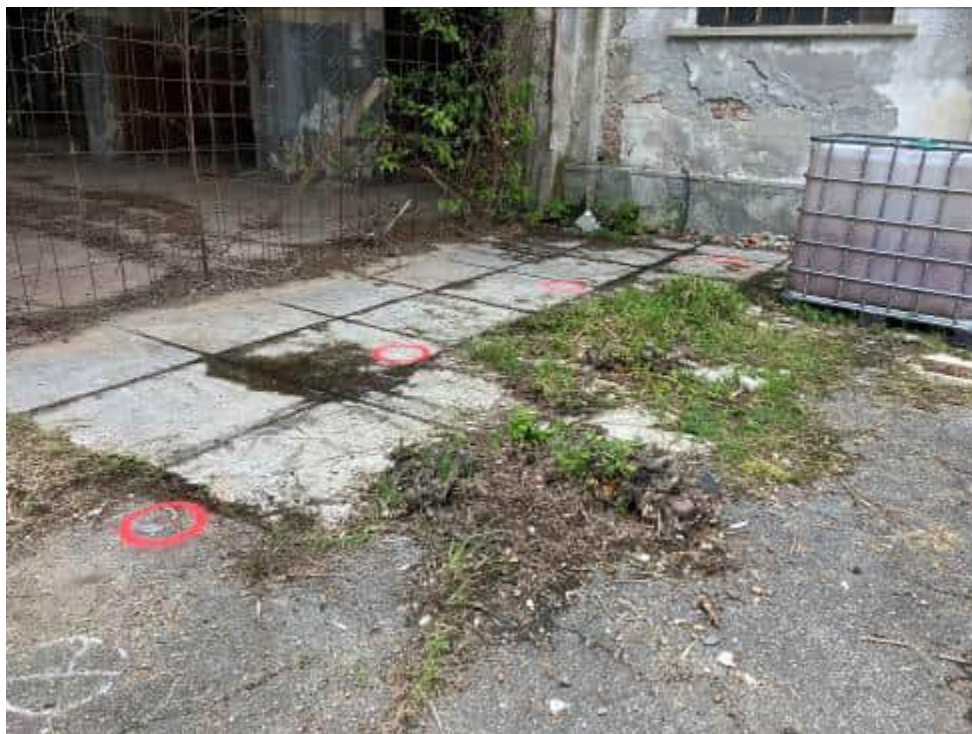
Foto 2: Individuazione punti di iniezione tramite indagine georadar (area BH18)
