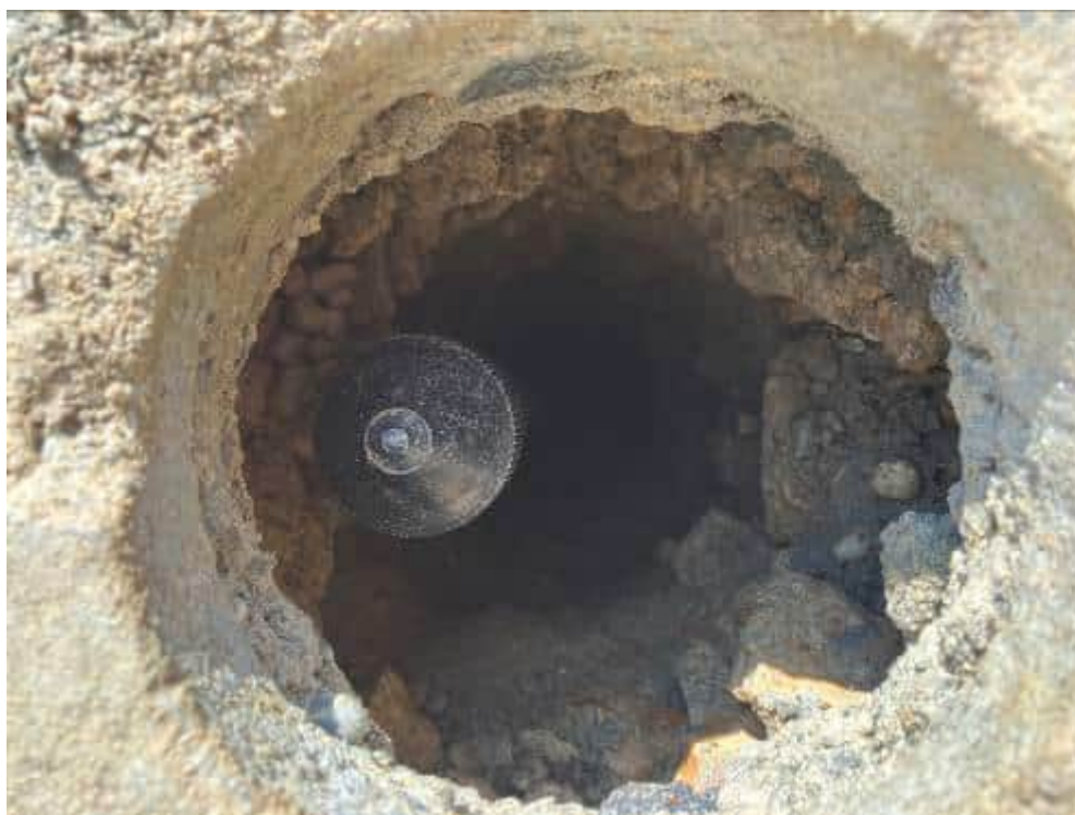
Foto 7: Tubi valvolati installati
