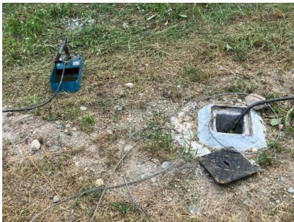
Foto 18: Installazione sistema di iniezione
