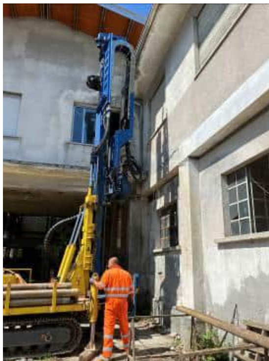
Foto 4: Posizionamento sonda per inizio perforazione.
