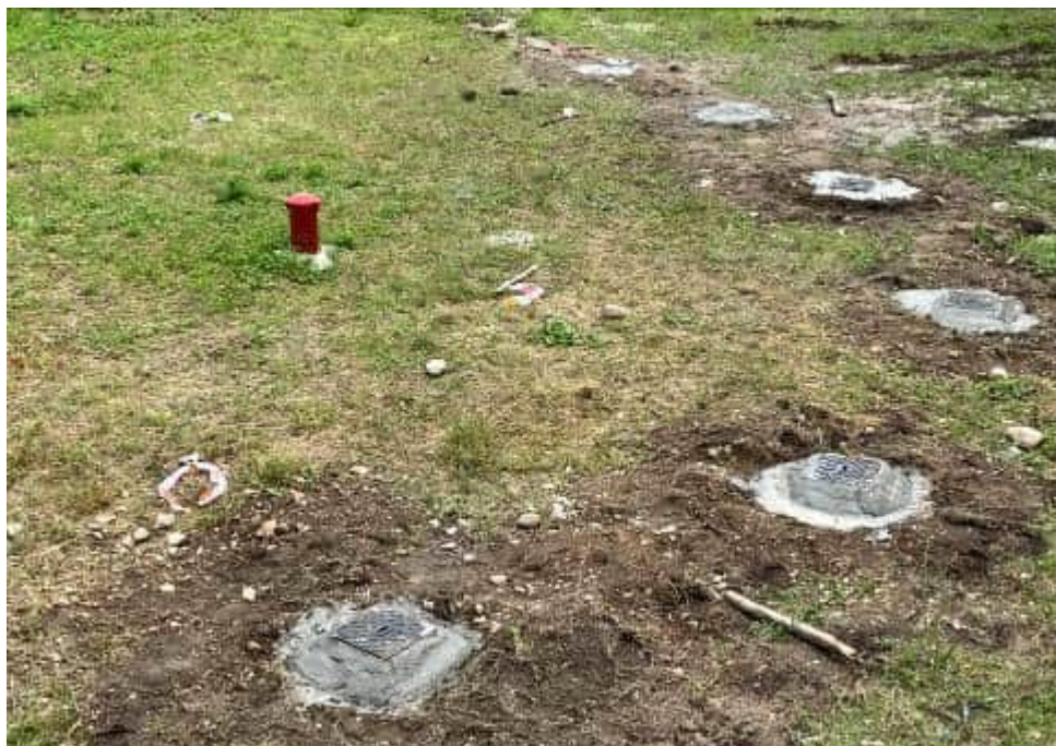
Foto 11: Pozzi di iniezione completati (area BH11)
