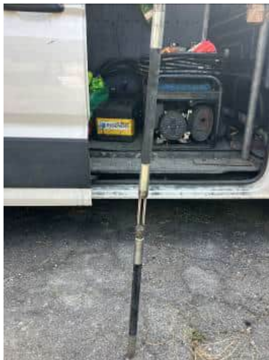
Foto 17: Packer per iniezione a diverse profondità
